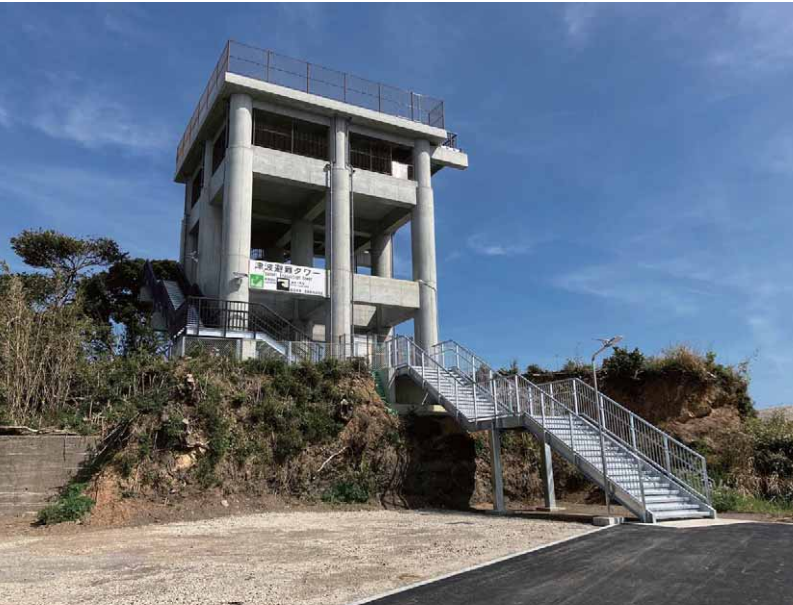
和具漁港・志摩町和具地区津波避難タワー
