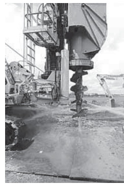
New-STJ工法 New-STJ-II工法 〈中掘り拡大根固め工法〉
